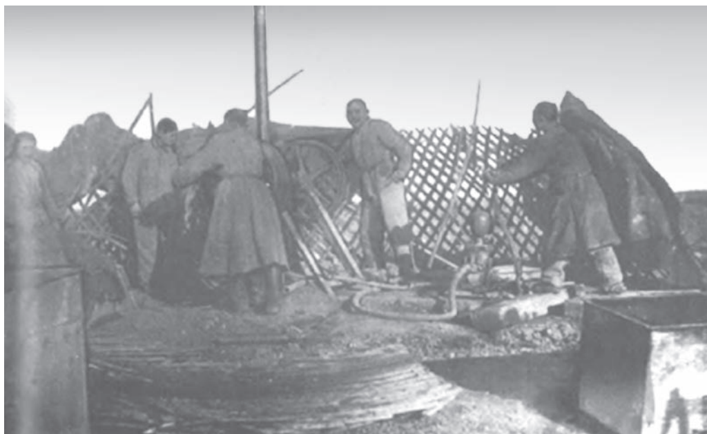
Рабочие-буровики из местного населения устанавливают буровой станок в казахской юрте. Карсакапай. 1934 г.
